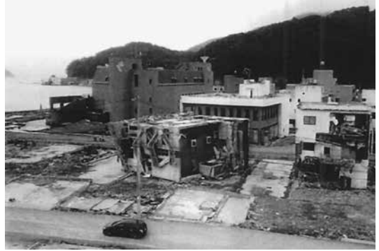
図8. 3階建てのコンクリートの建物の崩壊 (女川町)
