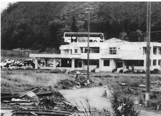
図9. 中央公民館の2階に打ち上げられたバス (雄勝町)
